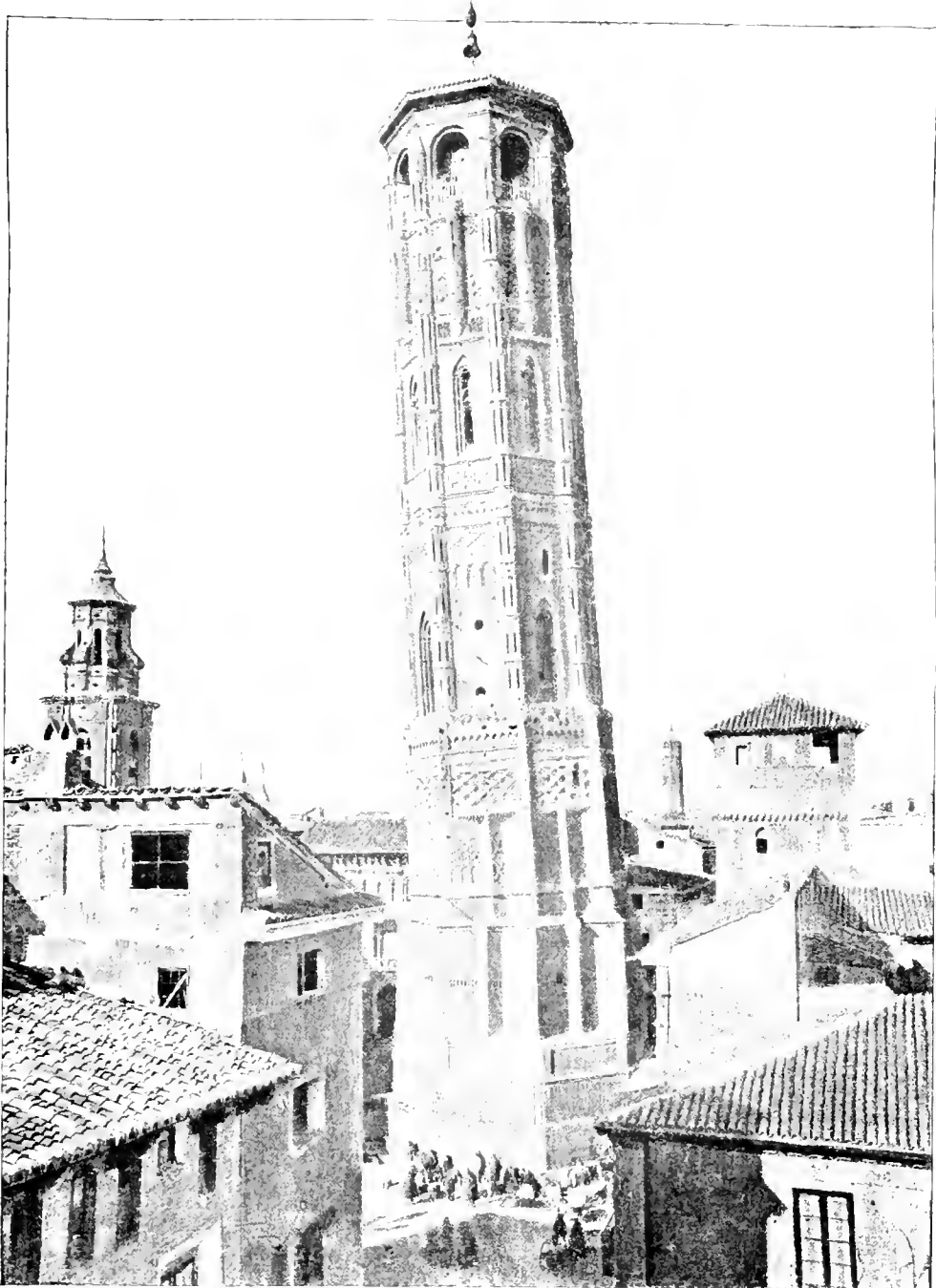
La Tour Neuve ou tour pechée de Saragosse.
